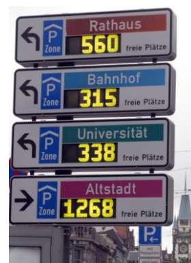
Abbildung 9: Dynamisches Parkleitsystem mit Restplatzanzeige
